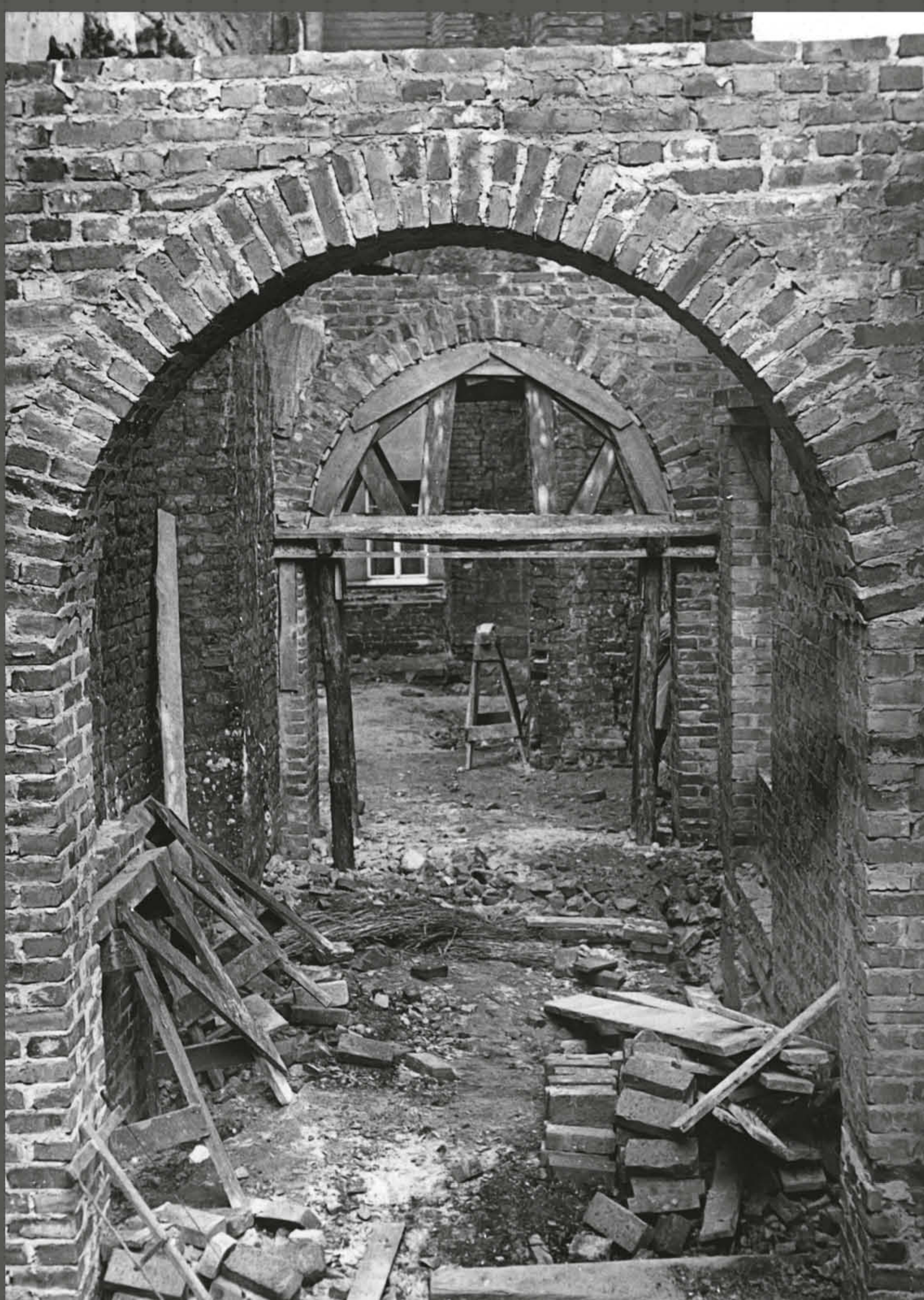
Odbudowa wnętrza na II piętrze. Fot. C. Czub (1962 r.) Rebuilding the interior on the second floor. Photo: C. Czub (1962)
