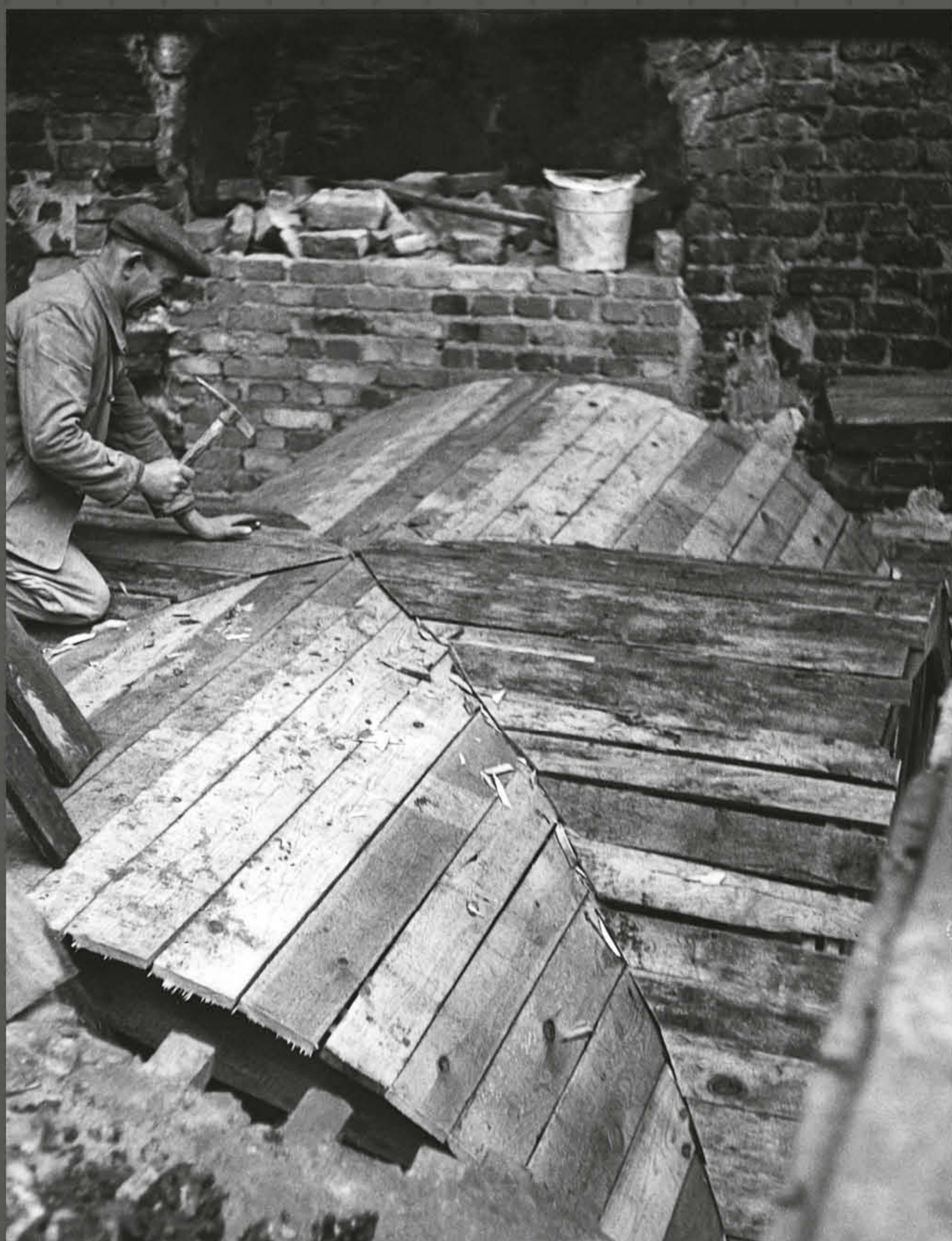
Odtwarzanie sklepień. Fot. C. Czub (1962 r.) Reconstruction of vaults. Photo: C. Czub (1962)
