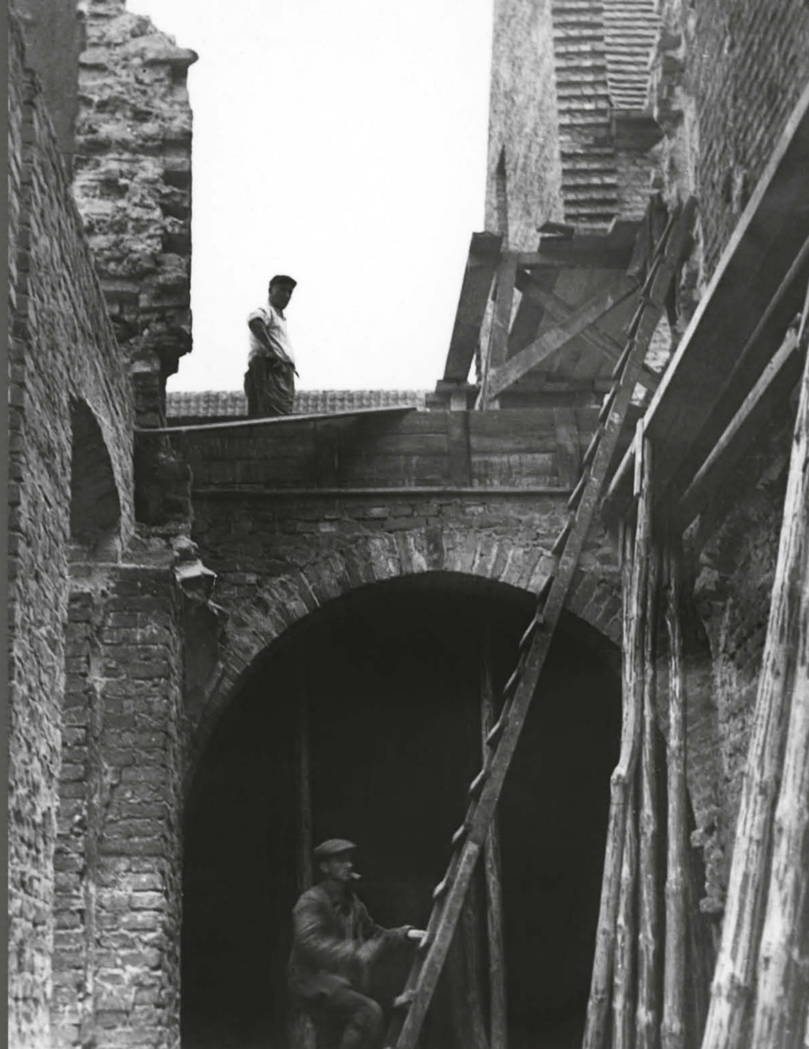
Prace przy odbudowie na wyższych kondygnacjach. Fot. C. Czub (1962 r.) Rebuilding works on upper floors. Photo: C. Czub (1962)
