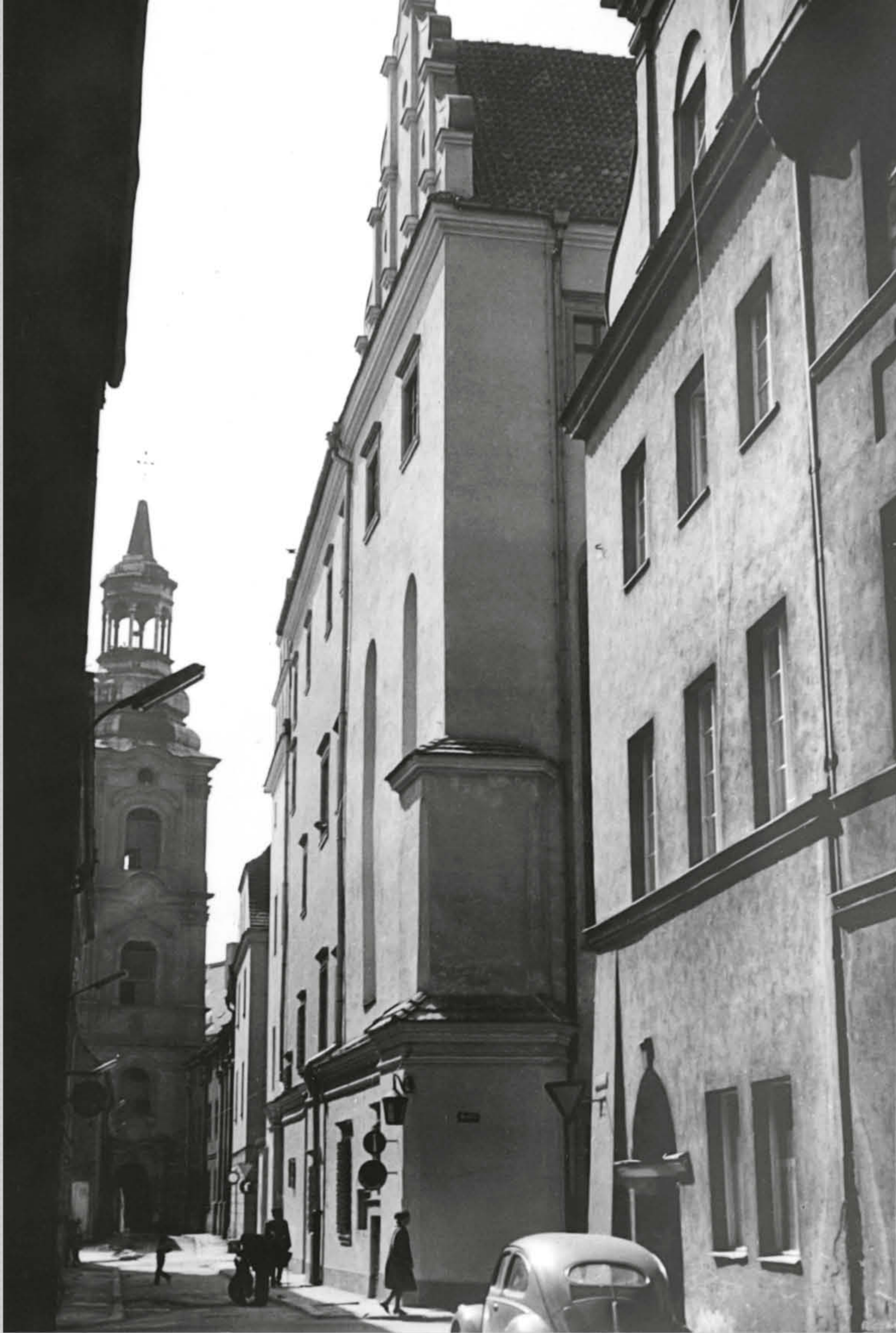
Na narożniku ulic Klasztornej i Wodnej. Fot. C. Czub (1967 r.)
