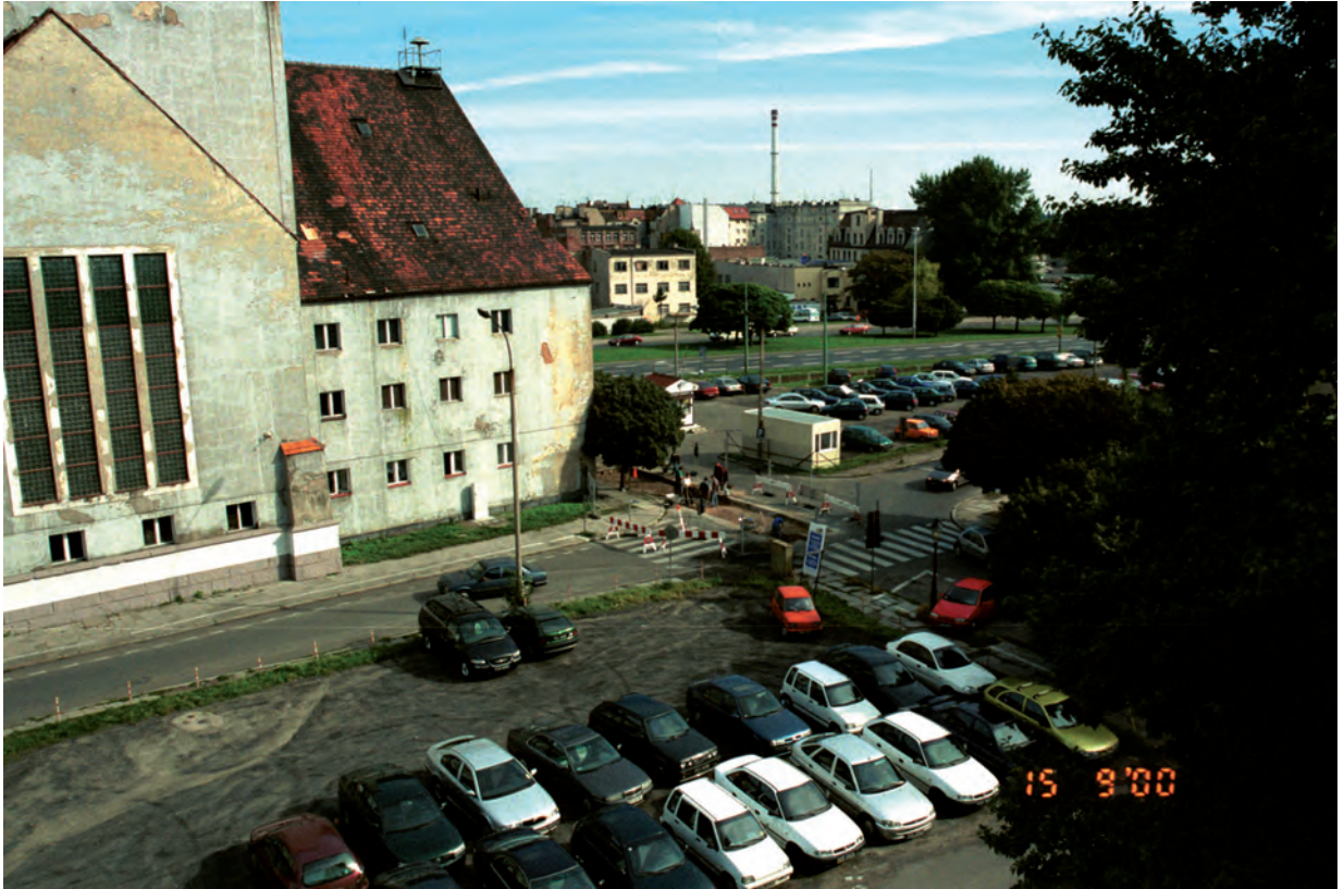
Fot. 1. Lokalizacja wykopu badawczego. Widok od SW. Fot. P. Namiota
