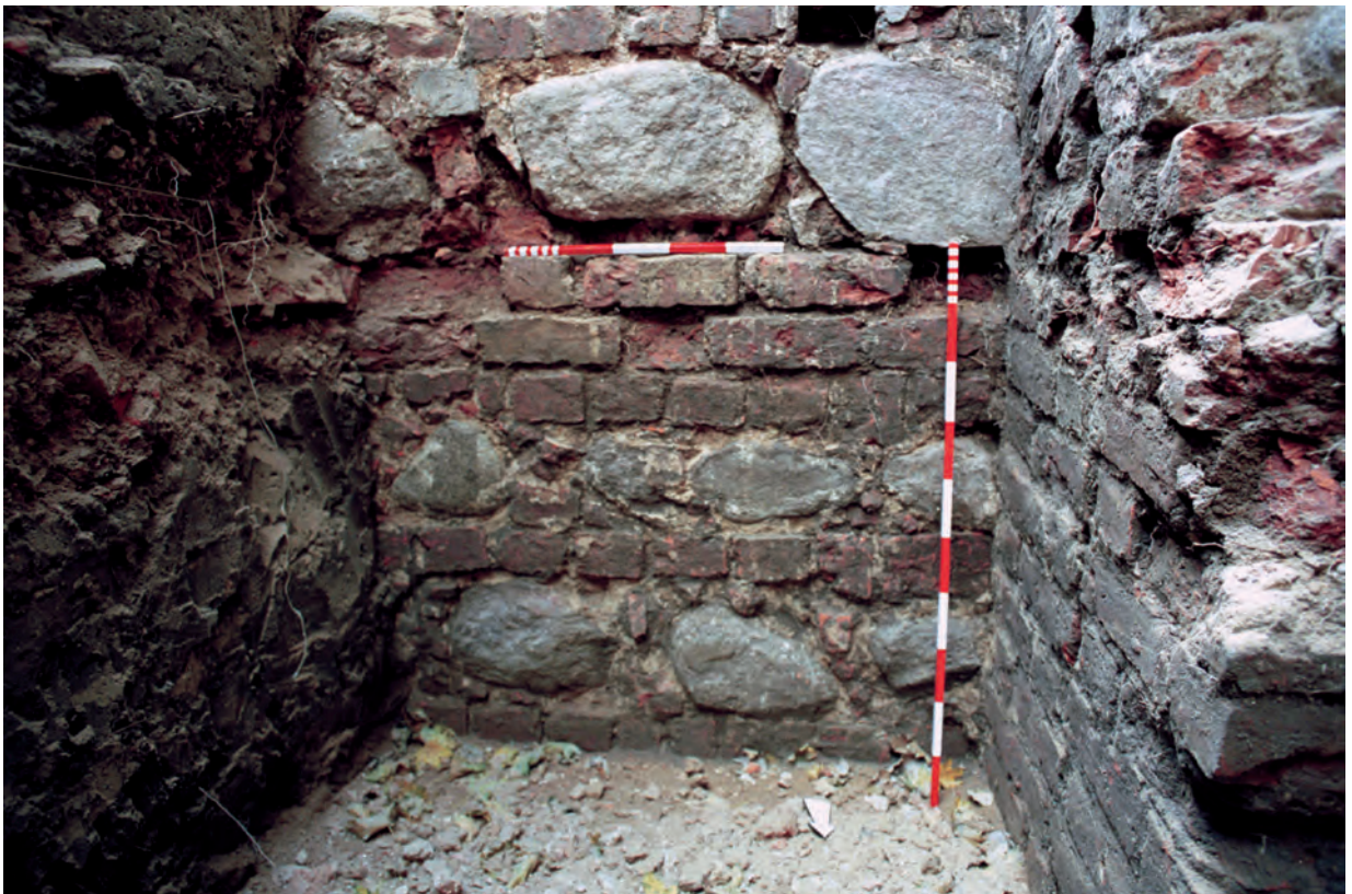
Fot. 30. Fragment lica północnego zewnętrznego muru obronnego. Widok od N. Fot. P. Namiota
