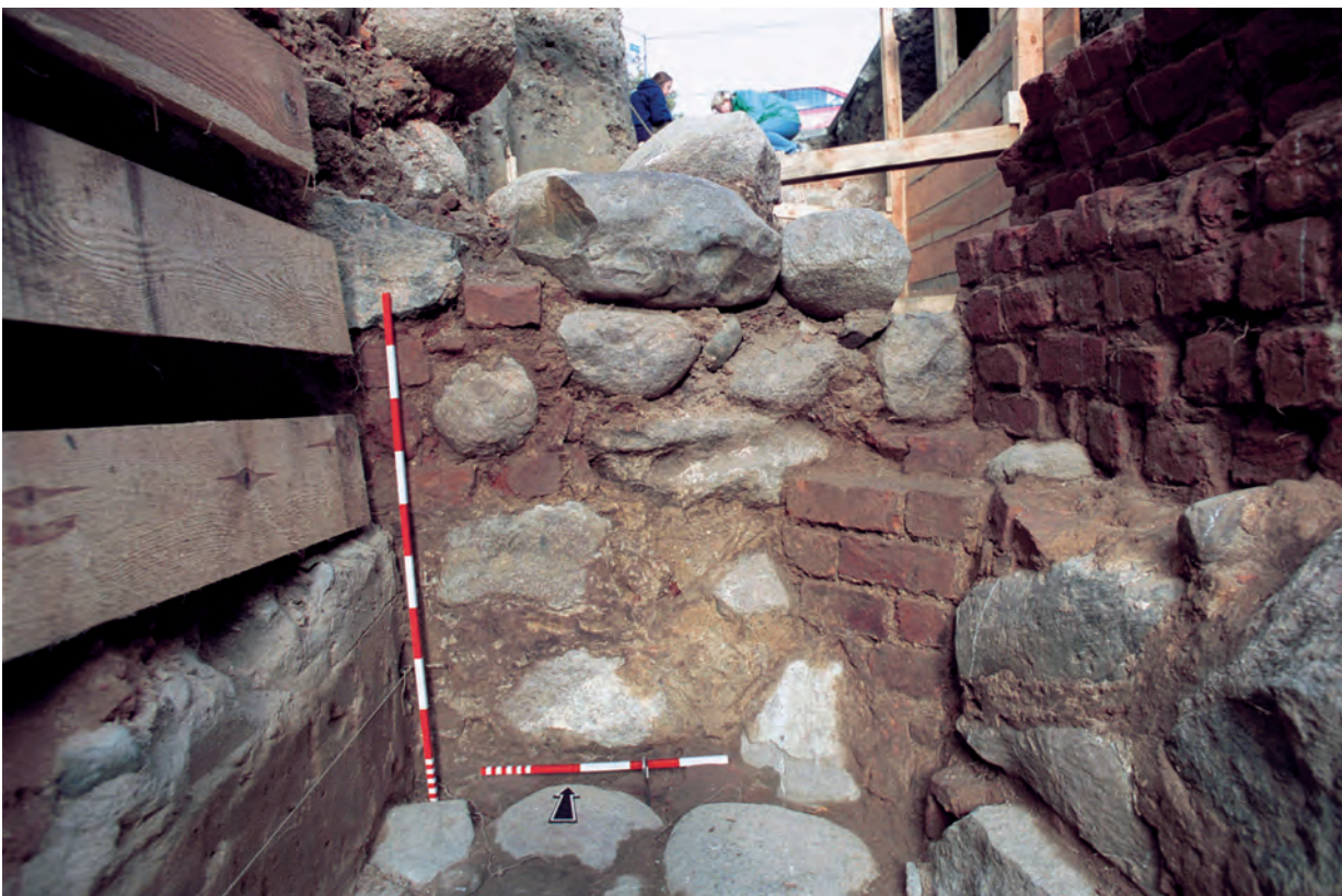
Fot. 12. Fragment południowego lica kamiennych fundamentów ściany północnej baszty. Widok od S. Fot. P. Namiota
