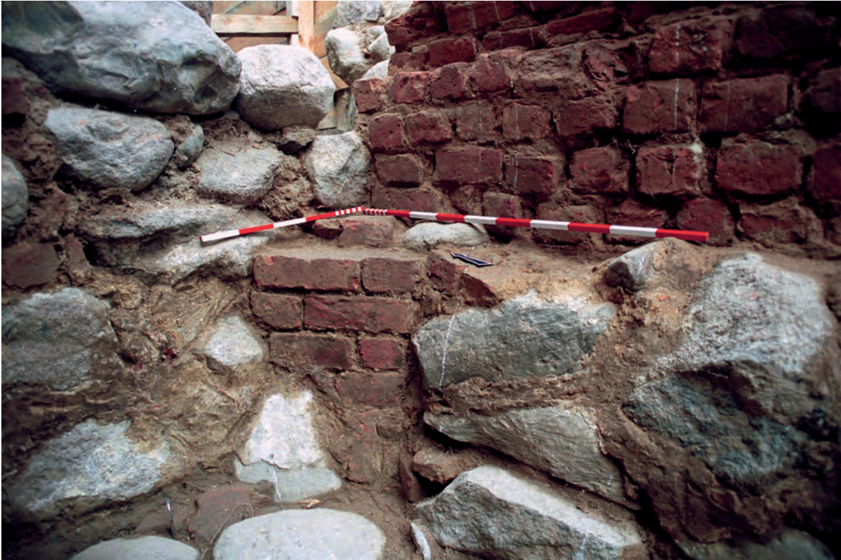
Fot. 15. Trójkątna konstrukcja ceglana stanowiąca być może podstawę żebra sklepienia krzyżowego. Widok od SW. Fot. P. Namiota
