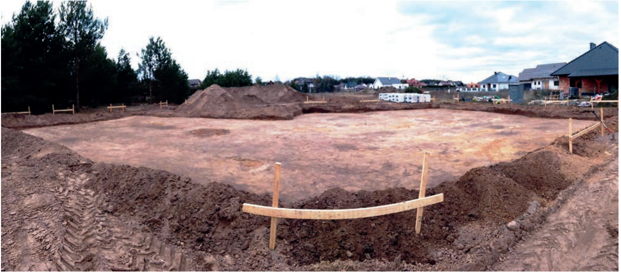
Ryc. 1. Kowanówko, stan. 20A, woj. wielkopolskie. Wykop nr I/19. Obiekty na tle stropu calca. Stan na 8 marca 2019 r. W tle powstające osiedle domów jednorodzinnych. Fot. P. Banaszak
