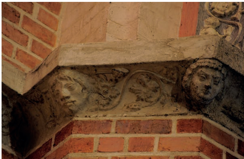
Gniezno. Katedra, dekoracyjny gzyms impostowy wykonany ze sztucznego kamienia, 2. poł. XIV w. Fot. J. Andrzejewski
