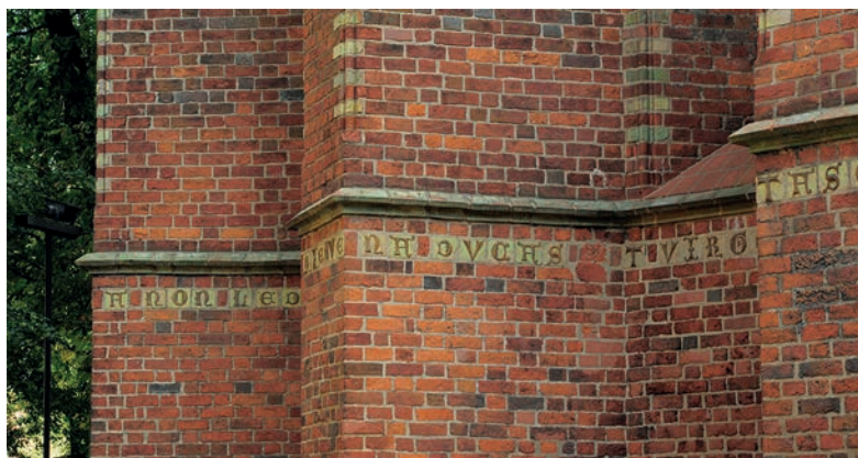
Toruń. Kościół św. Jakuba, inskrypcja na zewnętrznej ścianie prezbiterium, po 1309 r. Fot. J. Andrzejewski
