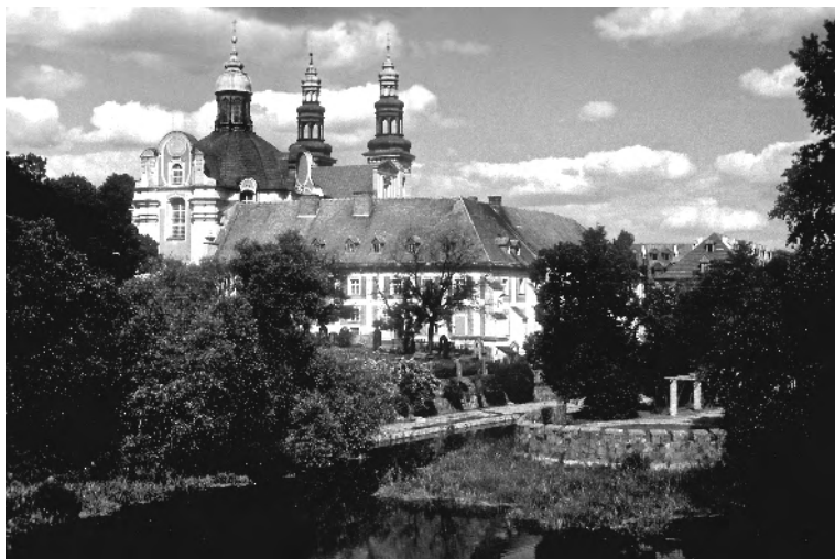
Ryc. 17. Widok opactwa w Łądzie od strony południowo-zachodniej. Fot. P. Namiota
