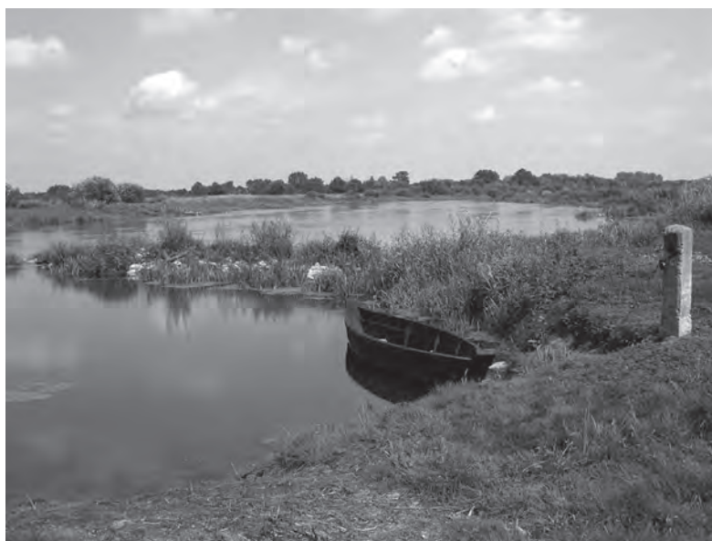
Ryc. 1. Koryto Warty pod Koninem wzmocnione kamiennymi ostrogami.
